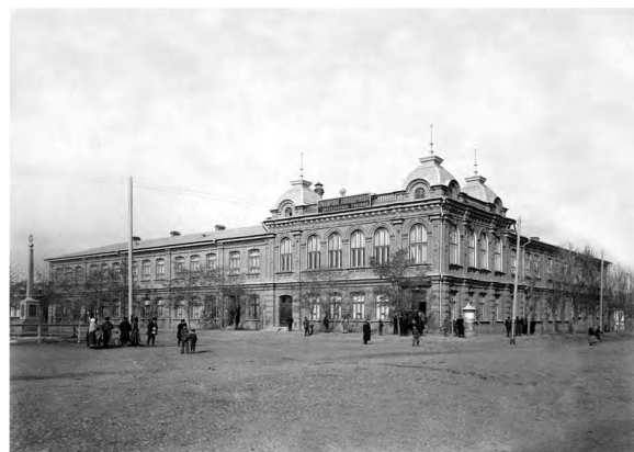
Рисунок 1.1 – Здание двухклассного городского Александровского училища
